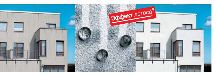
**Проблема традиционно используемых фасадных красок:** С течением времени загрязнения на фасадах становятся все более заметными. Особенно на наиболее подверженных атмосферным воздействиям сторонах. Здесь по причине большой влажности и отложении грязи на поверхности стен, микроорганизмы находят для себя идеальную питательную среду.
