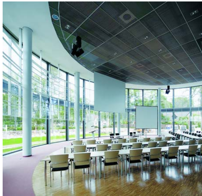
Воздухонепроницаемая пожаробезопасная акустическая плита StoSilent A-Тес Alu герметизирует проходящие под потолочным основанием короба вентиляционной системы. Уровнем ниже расположен подвесной потолок из металлической сетки, который обрамлен по периметру акустической системой StoSilent Panel.
