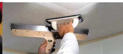
Монтаж панельных систем | 51
