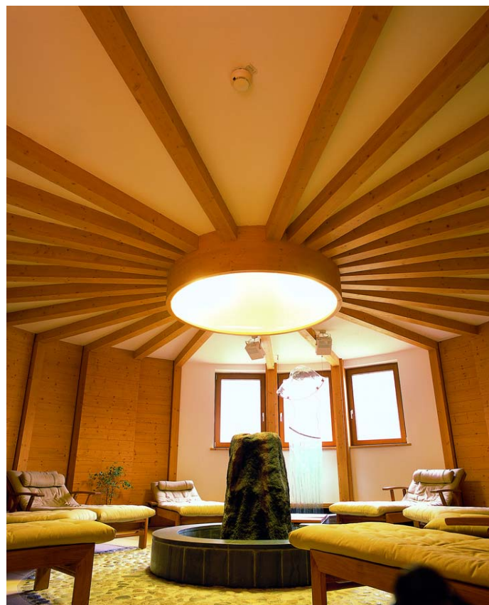
Потолок обустроен герметичной системой StoSilent Panel Alu, установленной непосредственно под кровлей здания и разделенной на сегменты деревянными балками в духе традиционного альпийского интерьера.
