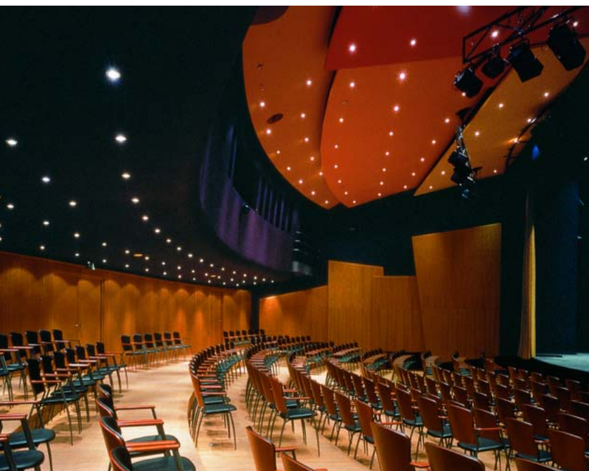
Акустическую основу этого зала составляет потолочная система StoSilent Panel черного цвета. В оформлении стен использована ее модификация StoSilent Panel Robust с повышенной устойчивостью к механическим нагрузкам, выкрашенная в темно-желтый цвет. Над сценой и партером смонтирована конструкция из звукопоглощающих и звукоотражающих элементов StoSilent Panel и StoSilent Panel Reflex в красно-оранжево-желтой цветовой гамме.
